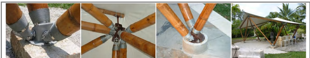
Figura 2.2.21 Unión cónica abrazando con cable metálico.
