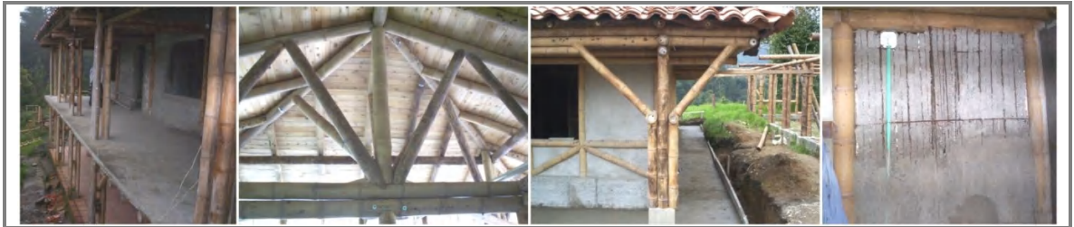
Figura 2.2.6 Casa en guadua en etapa de construcción.
