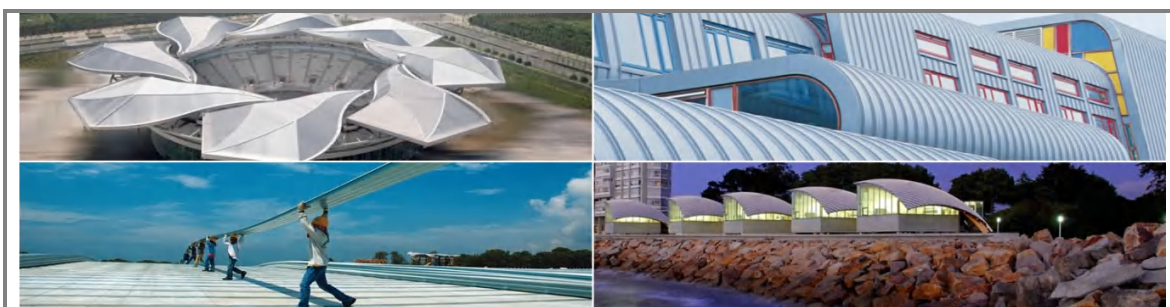
Figura A.16 Construcciones con cerramientos Kalzip.
