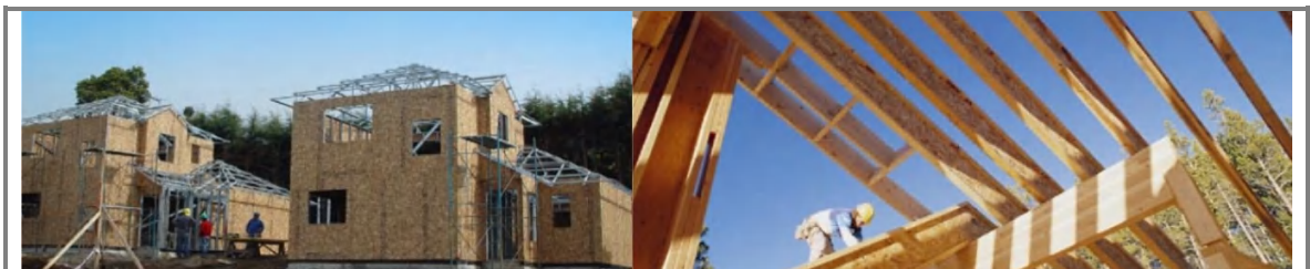
Figura A.5 Construcciones realizadas con el sistema Louisiana Pacific.
