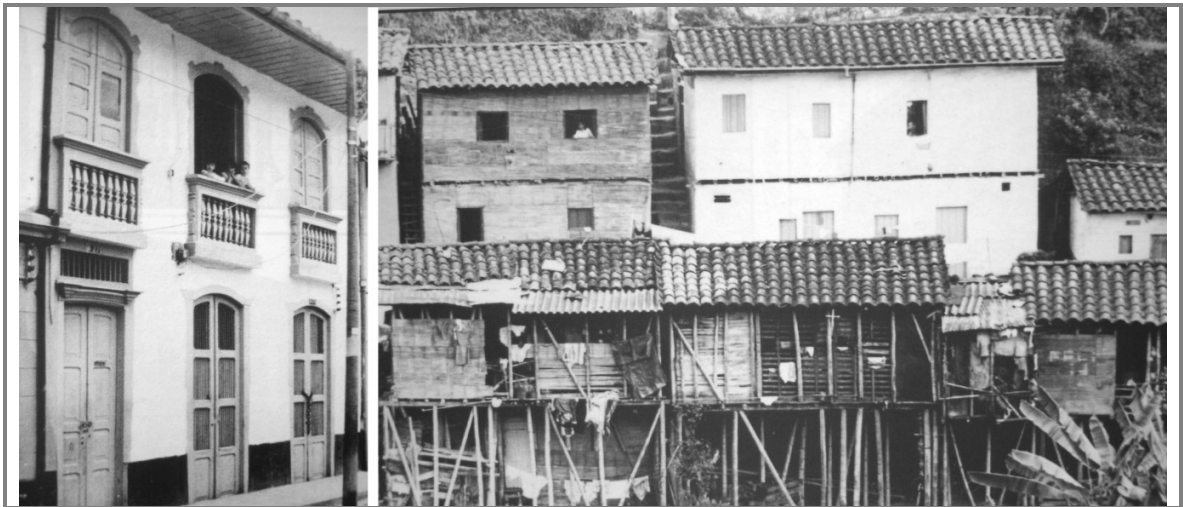
Figura 1.2 Construcciones en guadua en la ciudad de Manizales.
