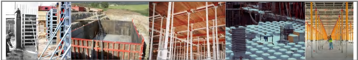
Figura A.12 Construcción con encofrados.
