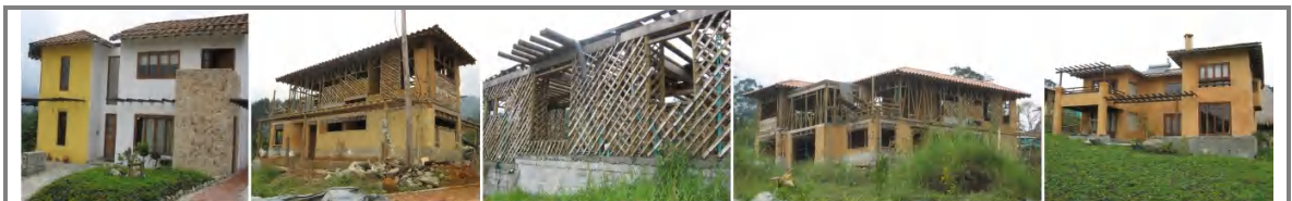
Figura A.23 Construcción de casas en bahareque, Unidad Residencial La Aldea. Municipio de La Estrella.
