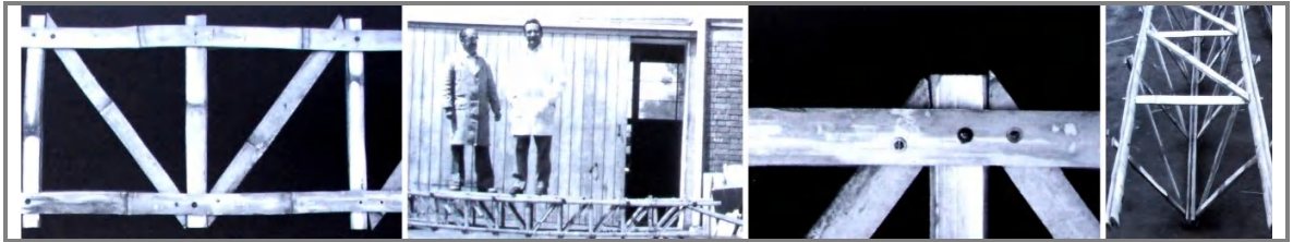
Figura 2.2.22 Cercha Warren con latas de bambú.
