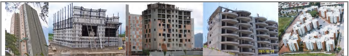
Figura A.14 Construcciones en realización. Sistema Forsa.
