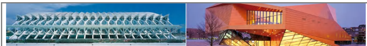
Figura A.15 Construcciones con cerramientos Kalzip.
